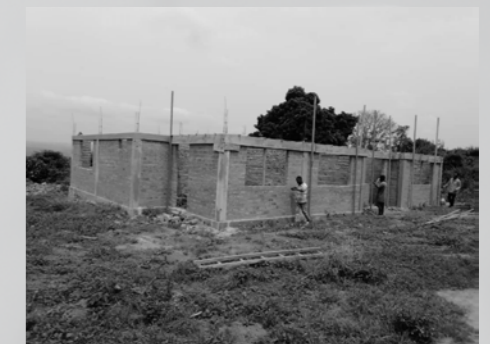
Proyecto de construcción de casas para médicos/as en Malembe (R.D. Congo)
